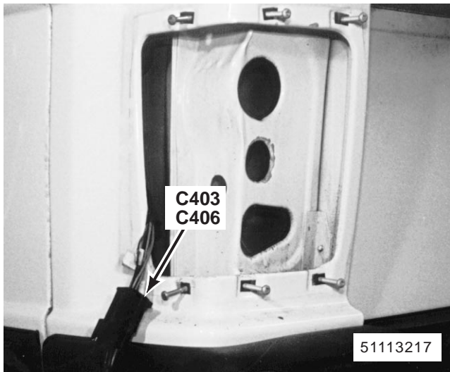
219. lado izquierdo del parachoques trasero (lado derecho similar)
